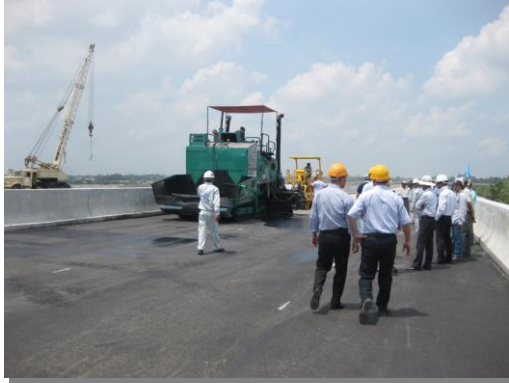
Thảm lớp BTN tạo nhám No va Chip
