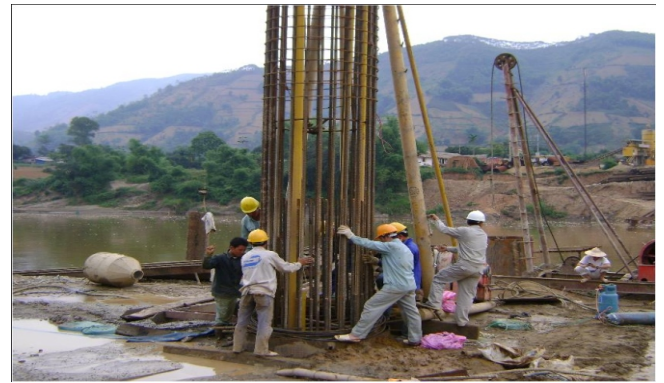
Giám sát thi công cọc khoan nhồi
