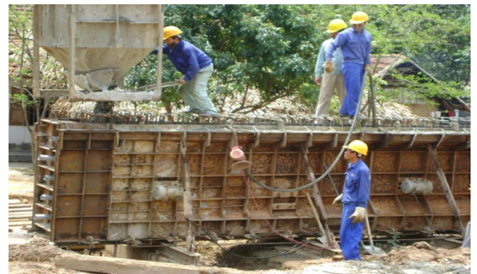
Giám sát thi công dầm cầu dự ứng lực
