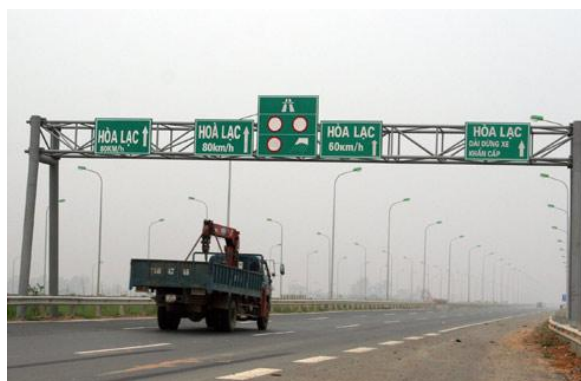
Hình 13. Thiếu vắng biển quy định tốc độ tối đa (biển trắng, hình tròn có viền đỏ) và biển giới hạn tốc độ tối thiểu (biển hình tròn, màu xanh) là nguyên nhân khiến người điều khiển ô tô nơm nớp lo bị phạt
