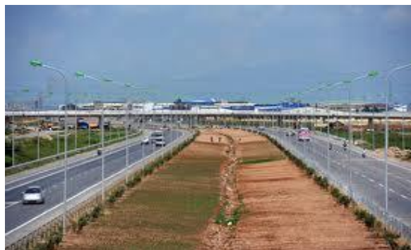
Hình 18. Dải phân cách giữa 2 đường cao tốc rộng 20m; 2 dải đất dự trữ giữa hai dải đường đô thị
