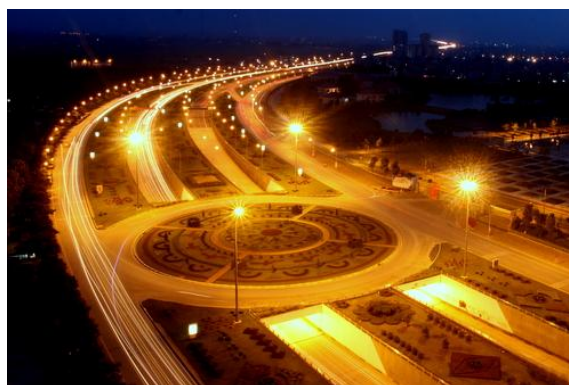
Hình 7. Hệ thống đèn đảm bảo chiếu sáng đầy đủ cả đêm lẫn ngày
