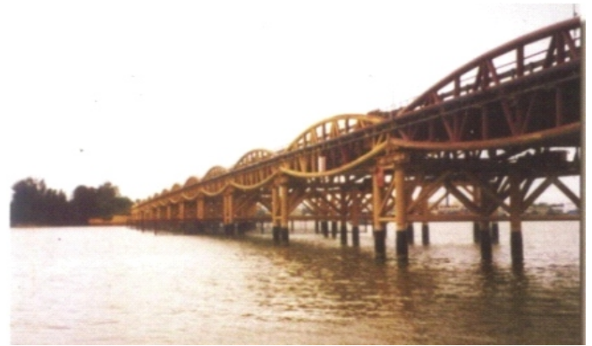
Bảo vệ cầu Nguyễn Văn Trỗi bằng hệ sơn cao su clo hoá, Epoxy Pek và Anot hy sinh
