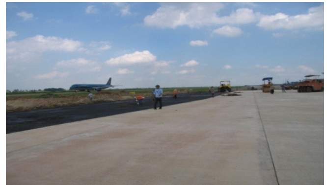
Tư vấn kiểm định, Giám sát thi công xây lắp đường lãn, sân đỗ tại Cảng Hàng không quốc tế Nội Bài.
