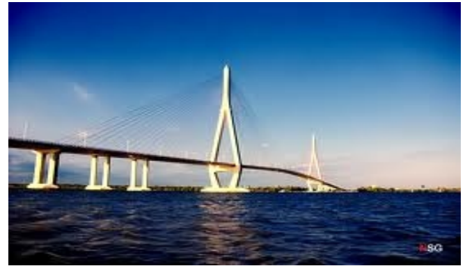
Đào tạo và chuyển giao công nghệ xây dựng cầu Cần Thơ.
