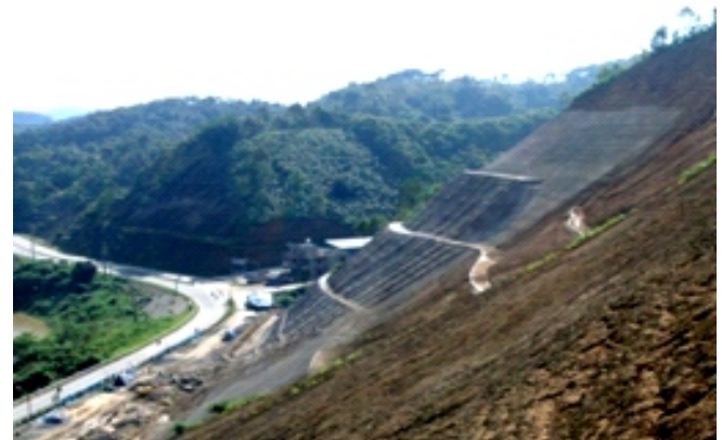
Khảo sát, thiết kế xử lý sạt trượt ứng dụng công nghệ neo ứng suất trước tại QL70, tỉnh Lào Cai
