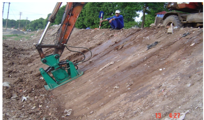
Thiết bị đầm ta luy kiểu rung động, đầm lèn mái ta luy
