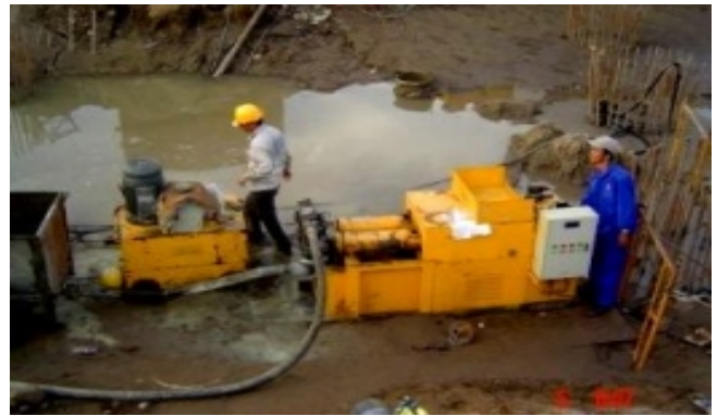
Thiết bị bơm vữa đóng cọc khoan nhồi
